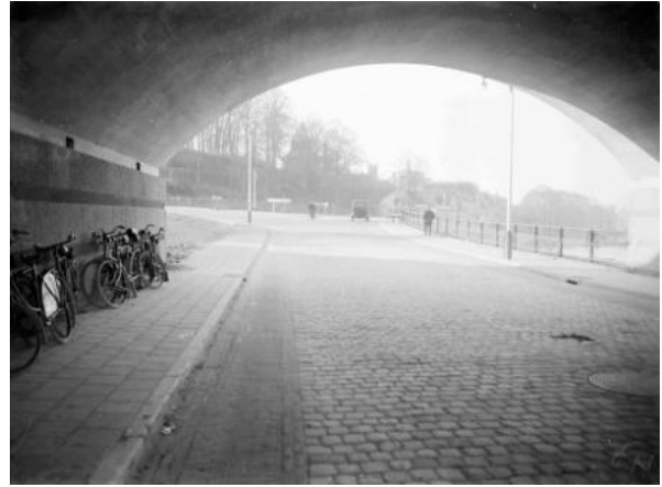
1936 – Ubbergseweg onder viaduct
